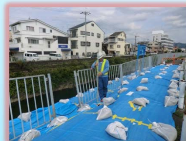
写真-3 応急処置状況
