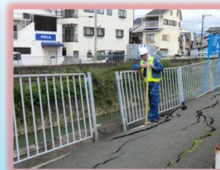
写真-2 陥没状況
