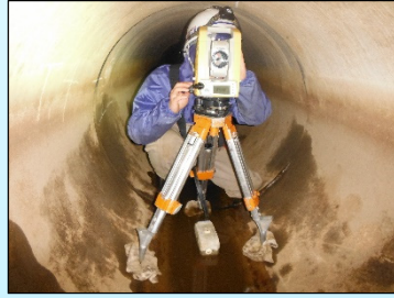
写真-5 管内観測状況
