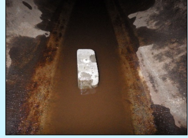
写真-6 基準点(仮ブロック)
