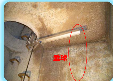
写真-4 通過状況
