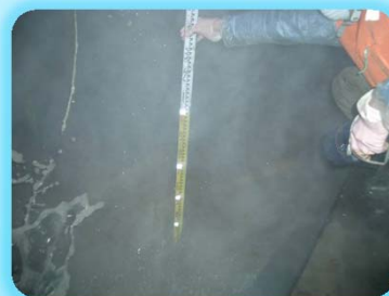
写真-1 水蒸気発生状況
